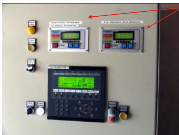
2 Bandrollen- auswertegeräte ASA BR30-4 zur kabellosen Bandüberwachung von 8 Bandanlagen
